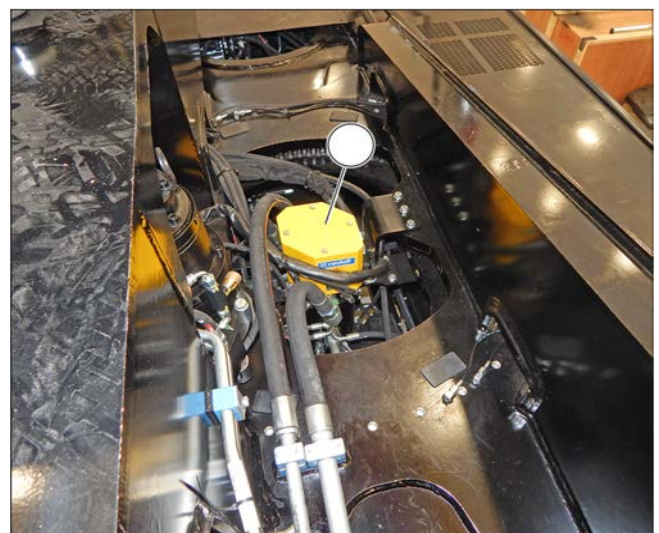
Afbeelding 224: De zenderringen van de roterende elektrische collector controleren en reinigen
